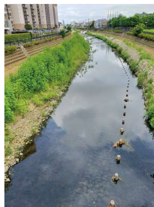
上:整備工事後の谷戸橋付近 右上:護岸工事後の緑の状況 右:河床に埋設された石
