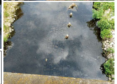
上:整備工事後の谷戸橋付近 右上:護岸工事後の緑の状況 右:河床に埋設された石
