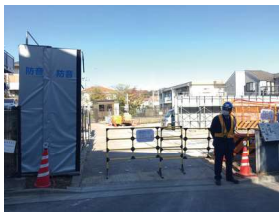
ボーリング調査のため閉鎖中のなかよし公園
