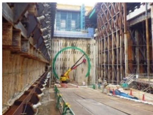
工事の写真(イメージ)
