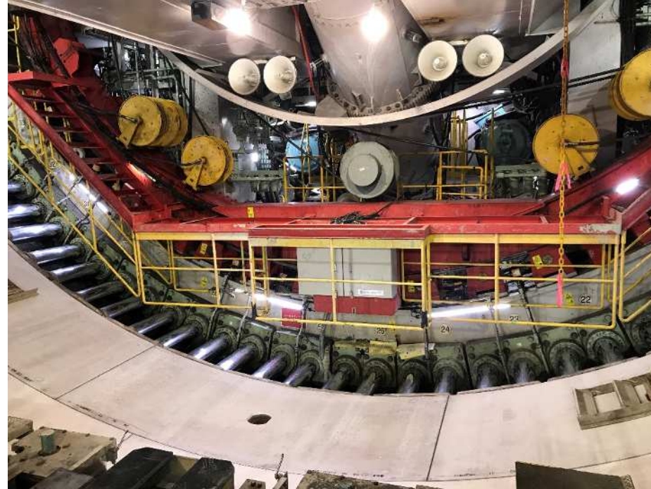
写真2 坑内状況写真(マシン下部)
