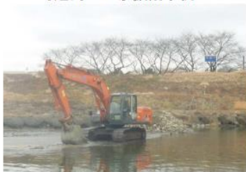
河道内の土砂掘削事例
